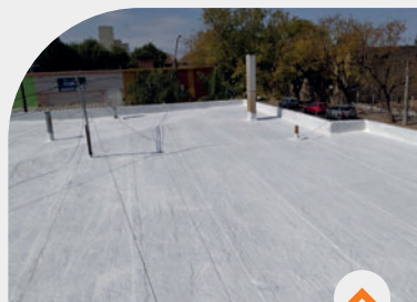
Terminal de Ómnibus. impermeabilización de la cubierta de techo: 600m 2 .
