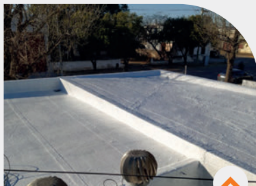
Registro Civil. Impermeabilización de techo 186m 2 .
