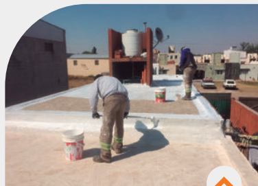
Se impermeabilizaron 34 viviendas de los complejos PROMUVI 1, 2, 3 y 4 1.857m 2 .
