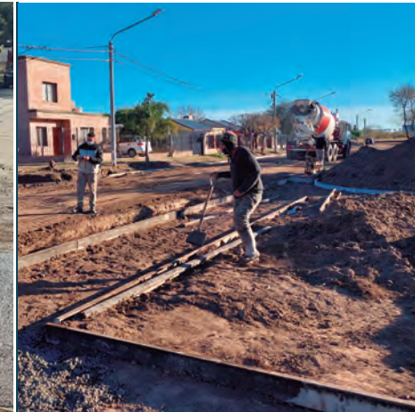
▼ Cordón Cuneta en Agua Mansa.
